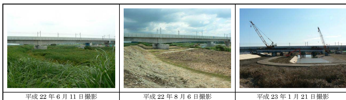
写真 3-4-1 合流部堤内地側の整備状況
