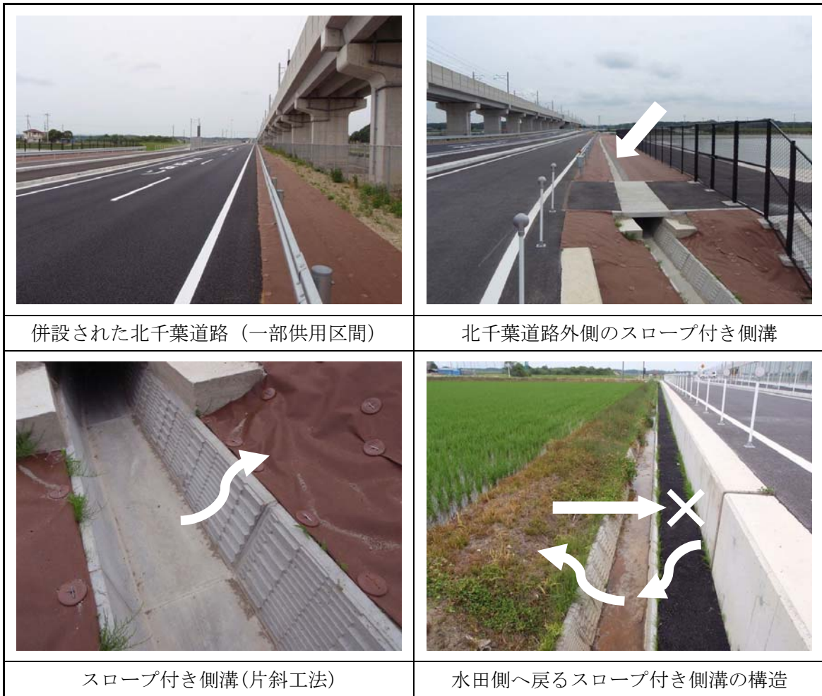
写真 3-2-3(2) 側溝設置状況 (2)
