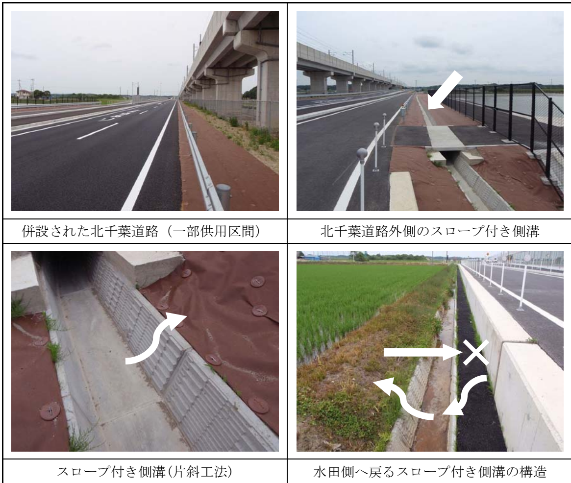
写真 3-2-3 (2) 側溝設置状況 (2)
